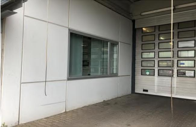
Abb. 1: Fugen zwischen Betonfertigteilen
